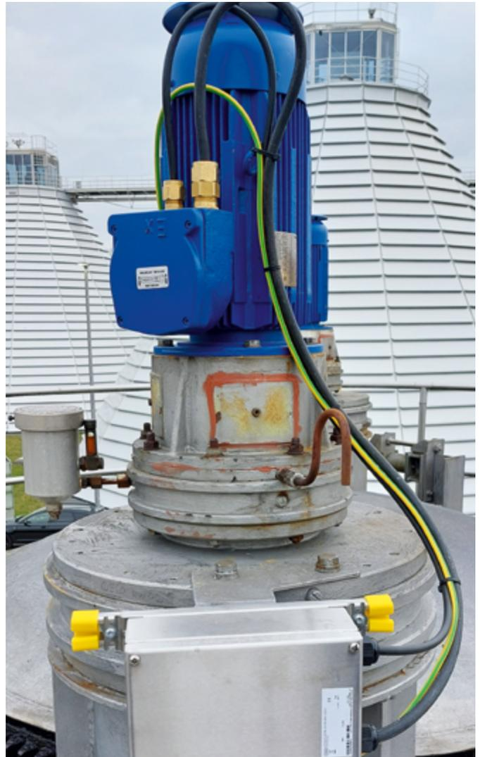
**ABBILDUNG 2:** NACH BETRIEBSSICHERHEITSVORORDNUNG, ANHANG 2, ABSCHNITT 3, NR. 5.2 SIND GERÄTE WIE DER HIER BEISPIELHAFT ABGEBILDETE MOTOR ZU PRÜFEN. © SANDY SCHIEBEL
